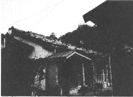
写真 12 屋根瓦の飛散 (垂水市役所提供)
