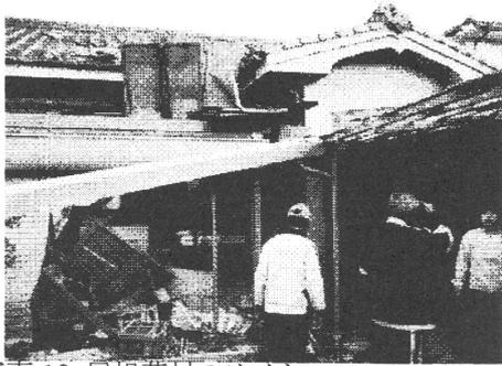
写真 10 屋根葺材のめくれ (垂水市役所提供)
