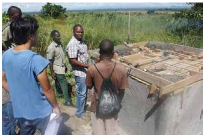
マラウイの村での水道建設
