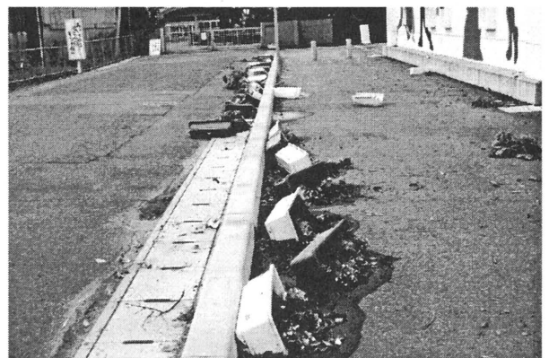
写真 11-① プランターの転倒
