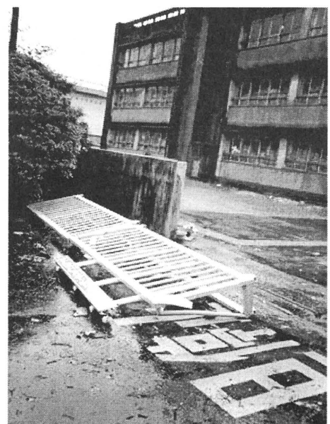
写真 11-② 門扉の転倒
