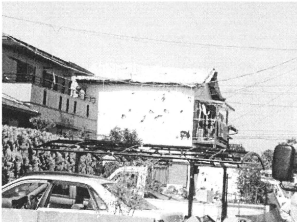
写真 6 飛散物の被害
