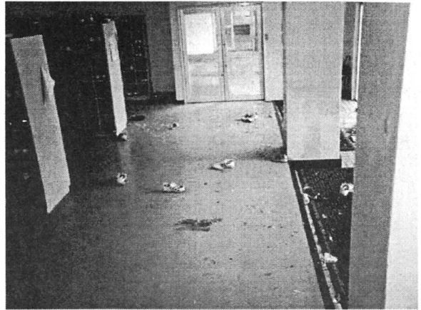
写真 11-⑦ 昇降口内部の被害
