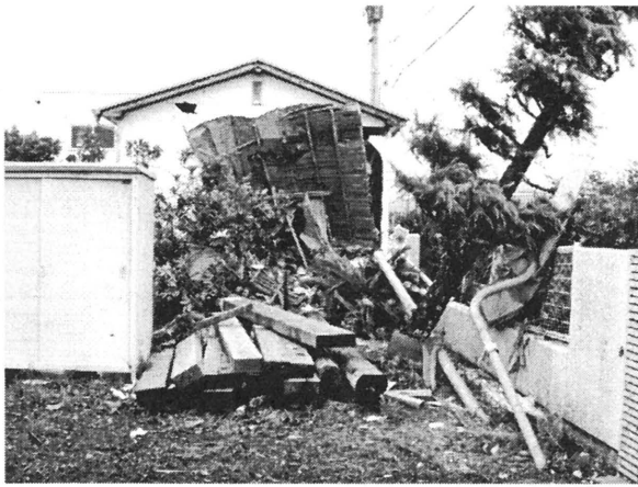
写真 5 飛散物の被害
