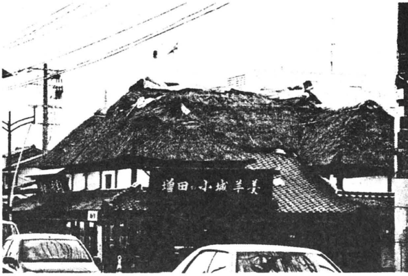
写真5 茅葺き屋根の飛散
