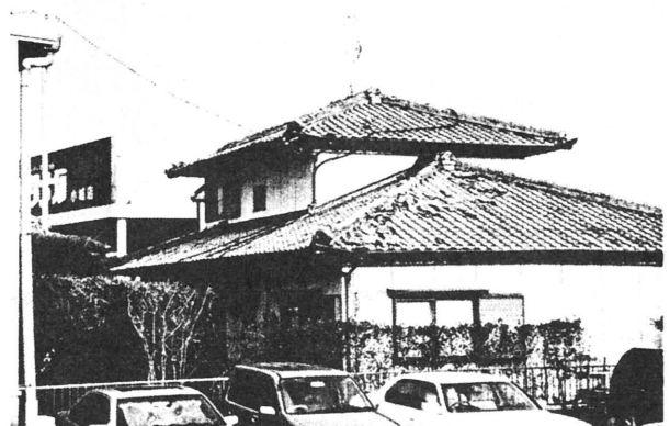
写真3 屋根瓦の飛散
