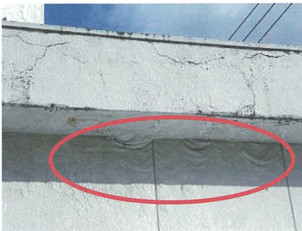
写真9 塗膜の膨れ (C-7)
