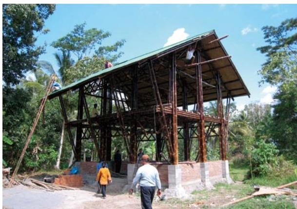
写真3 竹を建築資材として用いた建築中の2階建て家屋。土木工学部のムナワール教授のグループの研究成果。
