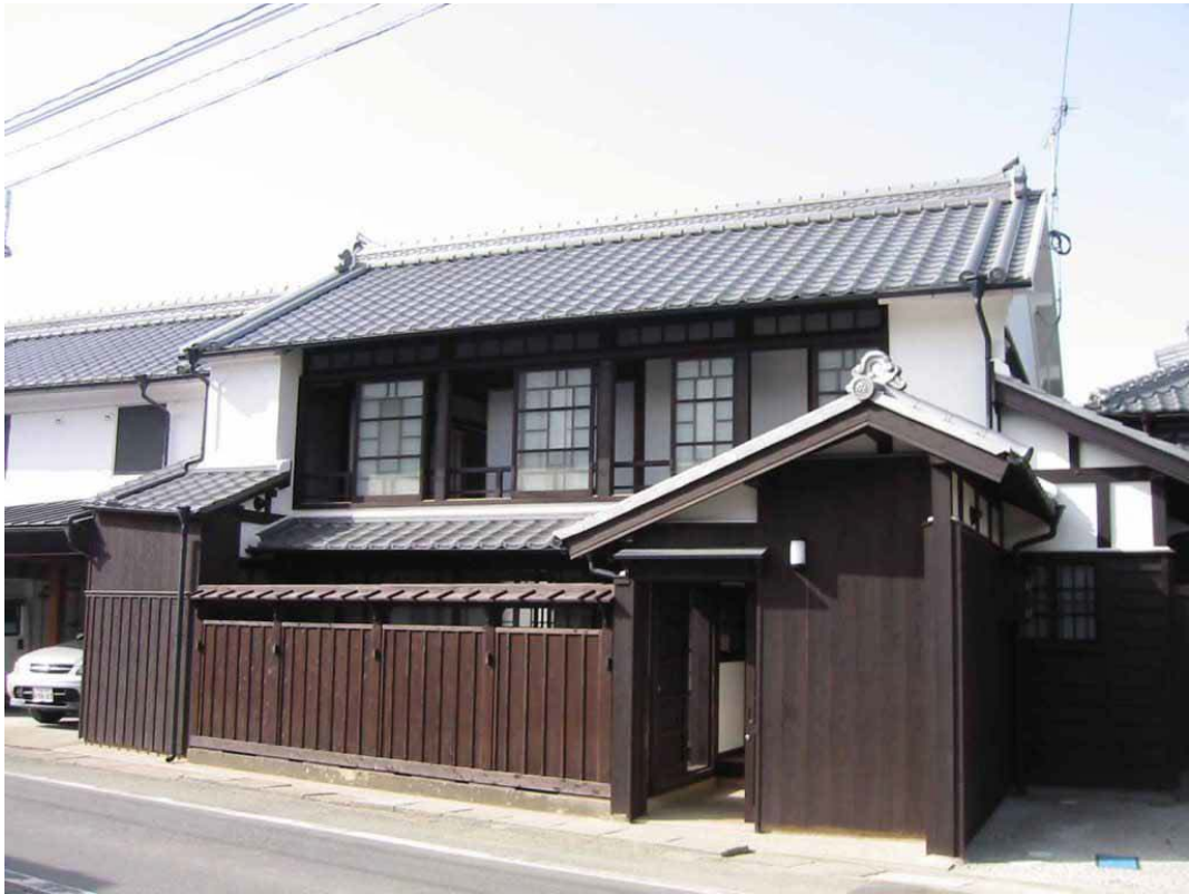
写真 4-12 修理後賃貸し、住居とした例
