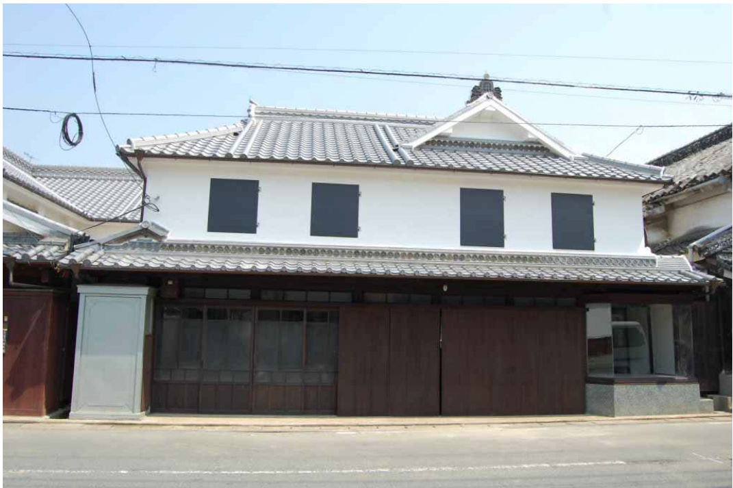
写真 4-6-2 修理事業（修理後）
