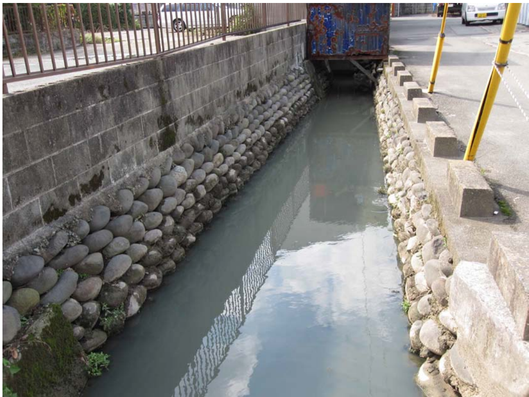
写真 4-19 流れが滞りがちな水路（中堀跡）
