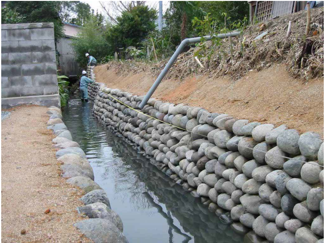
写真 4-18 玉石積み護岸を復原した水路整備
