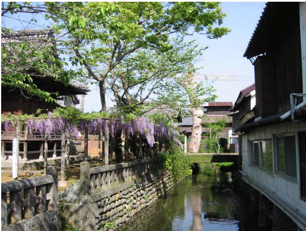
写真 4-4 外堀を継承する水路と玉石積み護岸
