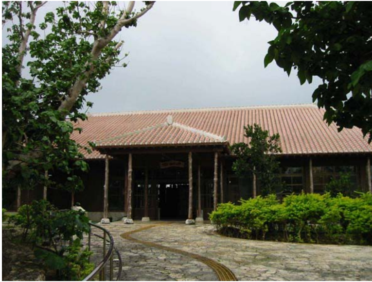
写真 3-14 ゆがふ館 正面
