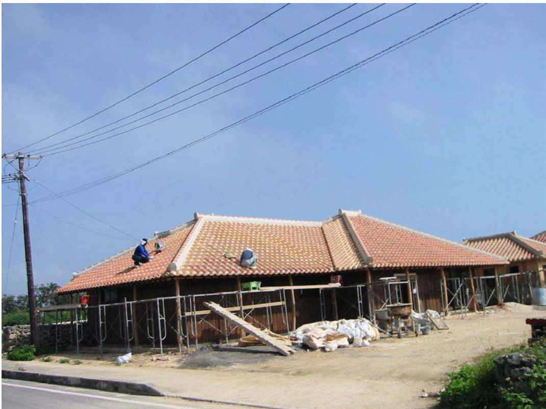
写真 3-19 建設中の修景家屋
