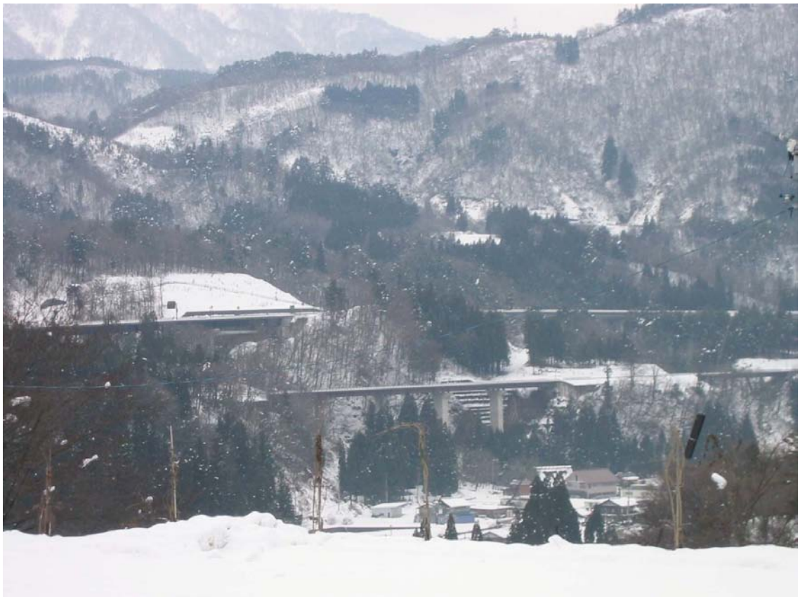
写真3-8 高速道路の高架（荻町展望台より）
