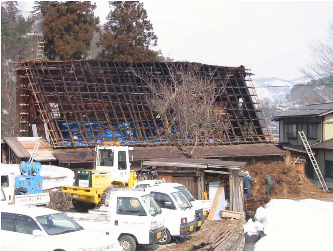
写真 3-4 修理事業による茅屋根の葺き替え
