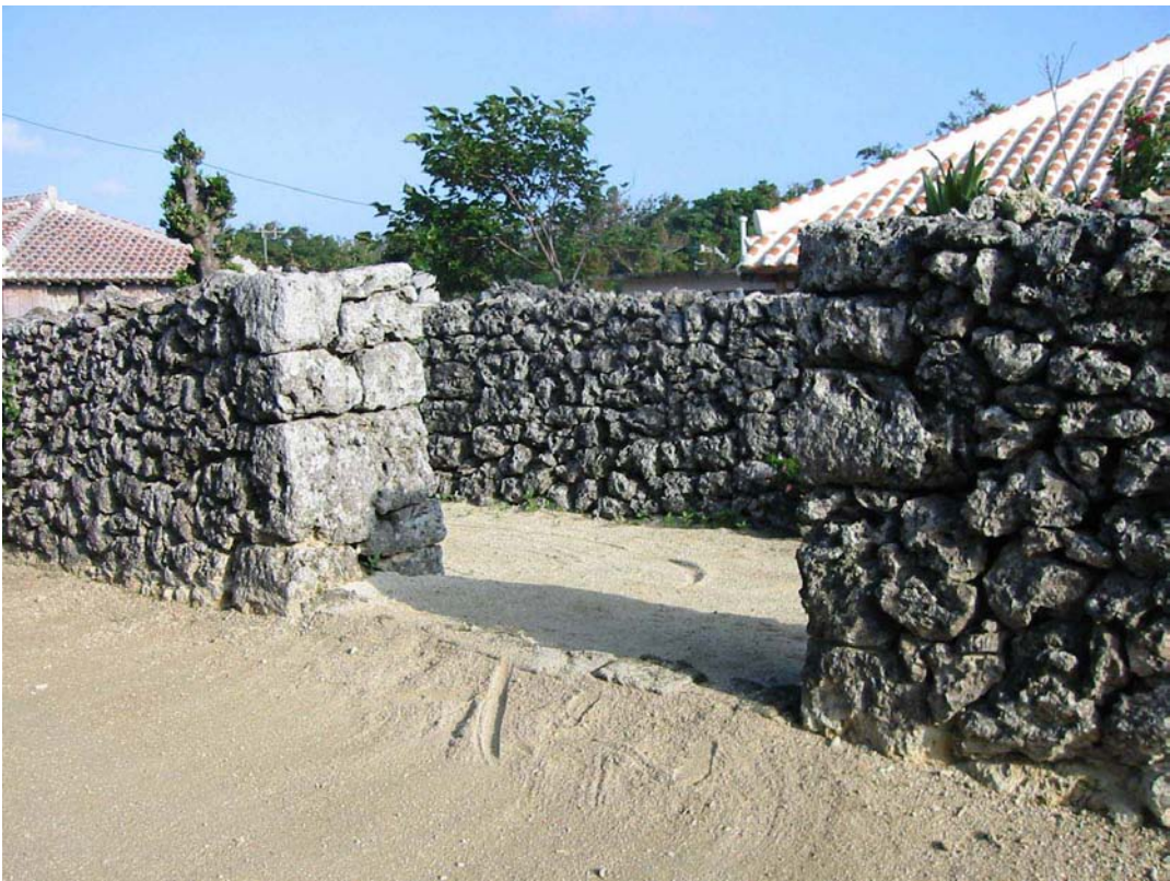
写真 3-23 嵩下げされた道路の敷地入口部分（嵩下げ前は敷地より道路面の方が高かった）
