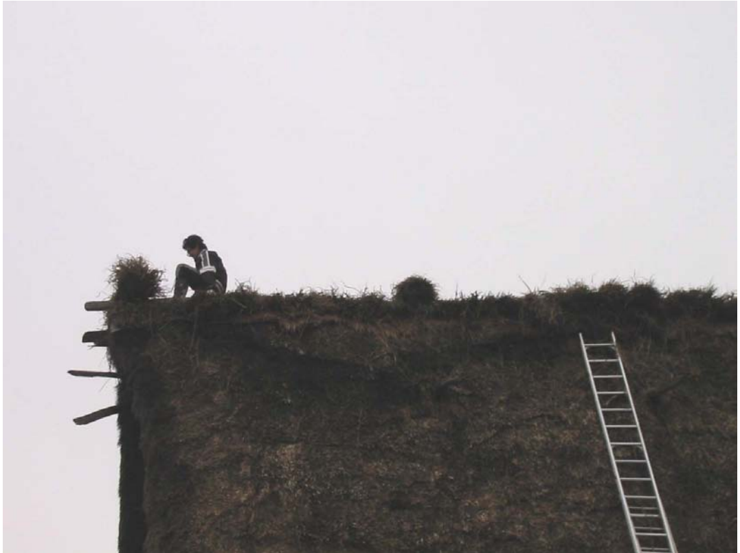
写真 3-10 棟茅の置き換え
