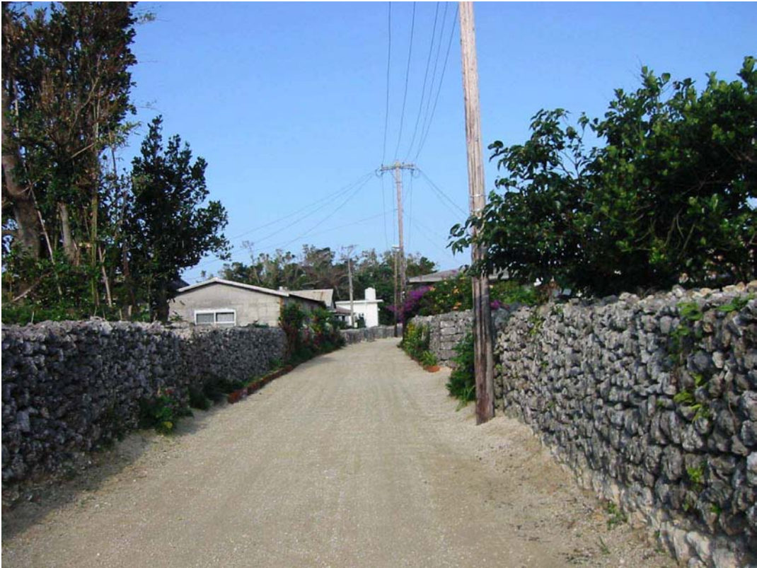
写真 3-22 嵩下げされた道路（石積み基部の白い部分は嵩下げ前は砂に埋まっていた）
