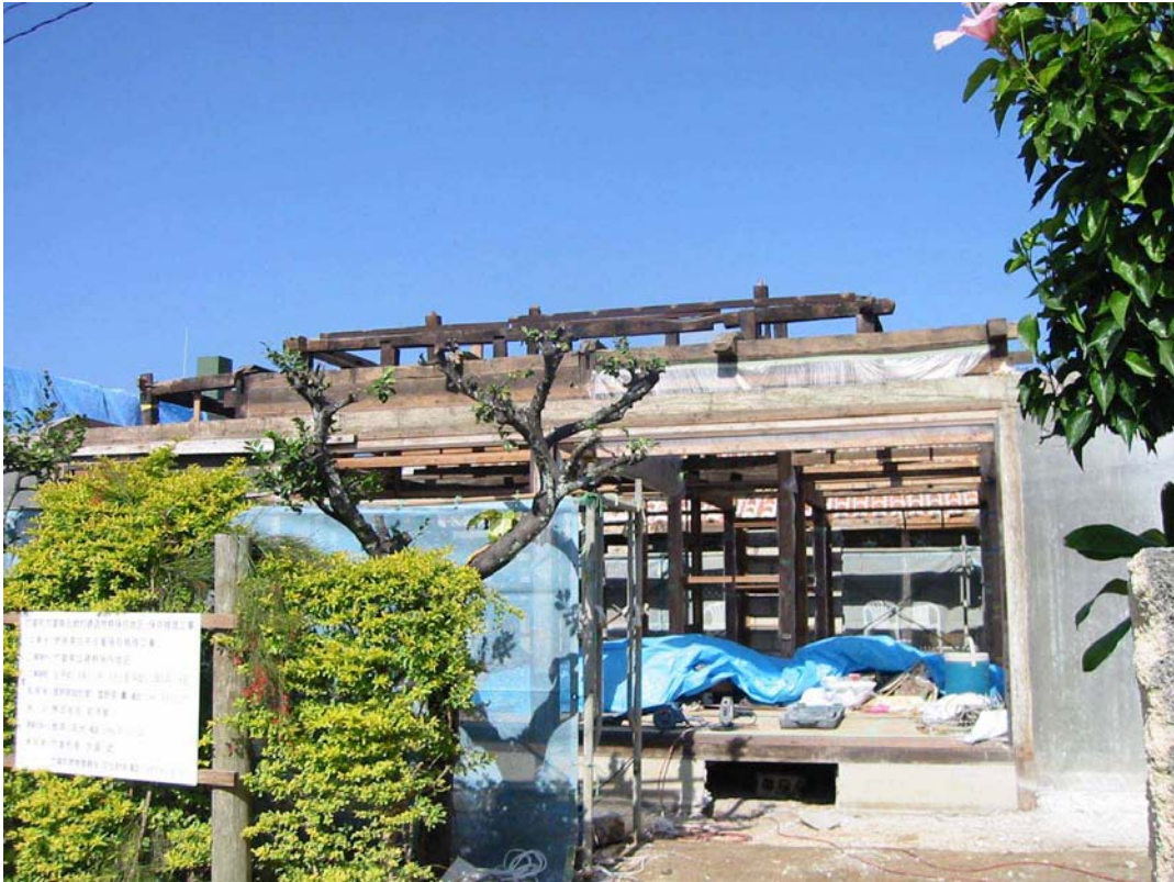
写真 3-16 修理中の家屋
