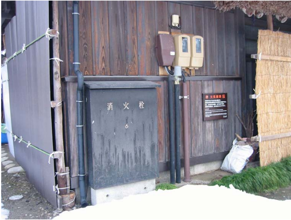
写真 3-6 電線地中化にともなう電線の引き込み線
