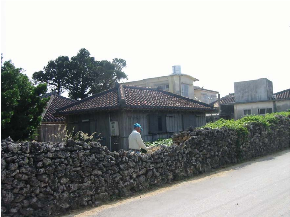
写真 2-7 石工による石垣の補修
