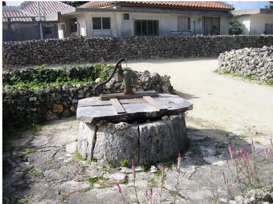
写真 2-11 掘り抜き井戸（敷地の外に出し共同で使用する）
