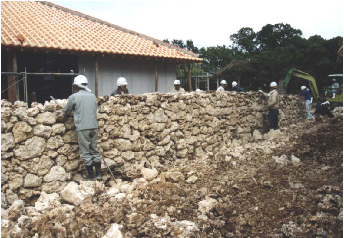
写真 2-12 島民総出による「まちなみ館」の石垣積み (撮影：西山徳明)
