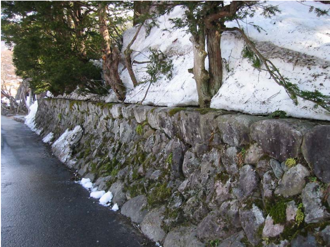
写真 1-5 明善寺の石積み
