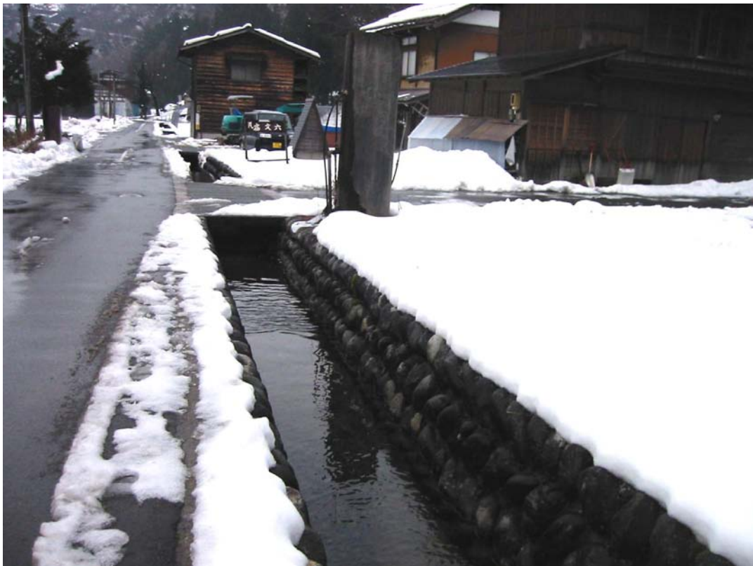
写真 1-13 修景による石積み護岸
