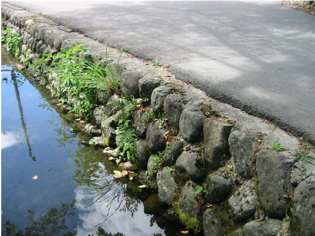
写真 1-12 伝統的な石積み護岸
