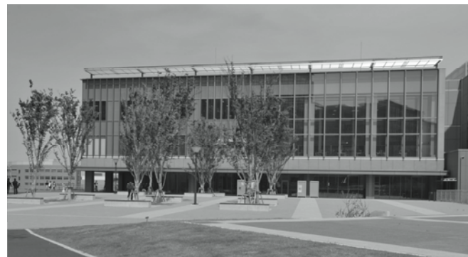
【施設概要】 建築面積：3,672.06㎡ 延べ面積：14,741.87㎡ 構造：鉄筋コンクリート造(一部鉄骨造) 地下1階地上3階 収蔵可能冊数：134万冊 閲覧席数：740席
