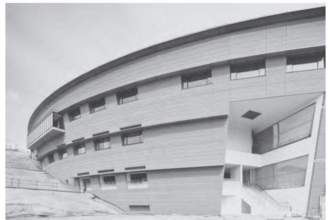
竣工した新中央図書館(1期)
