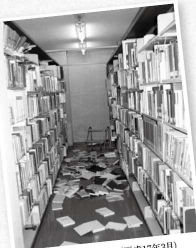
地震被害(3階開架)(平成17年3月)
