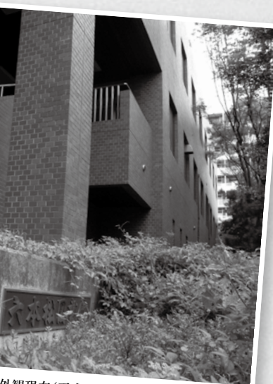
外観現在（平成20年）
