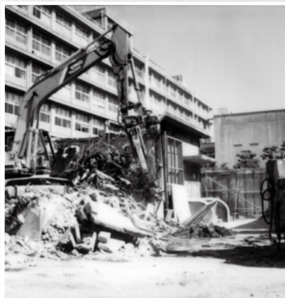
玉泉館解体(昭和62年10月14日)
