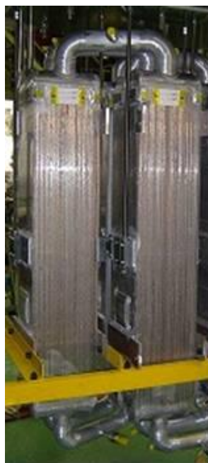
図 5.1-1 試作タービン式冷凍機 主熱交換器写真
