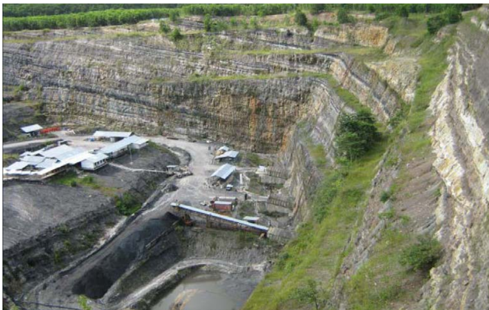
図 3.2 オーストラリア方式の坑口開設（Satui 炭鉱）
