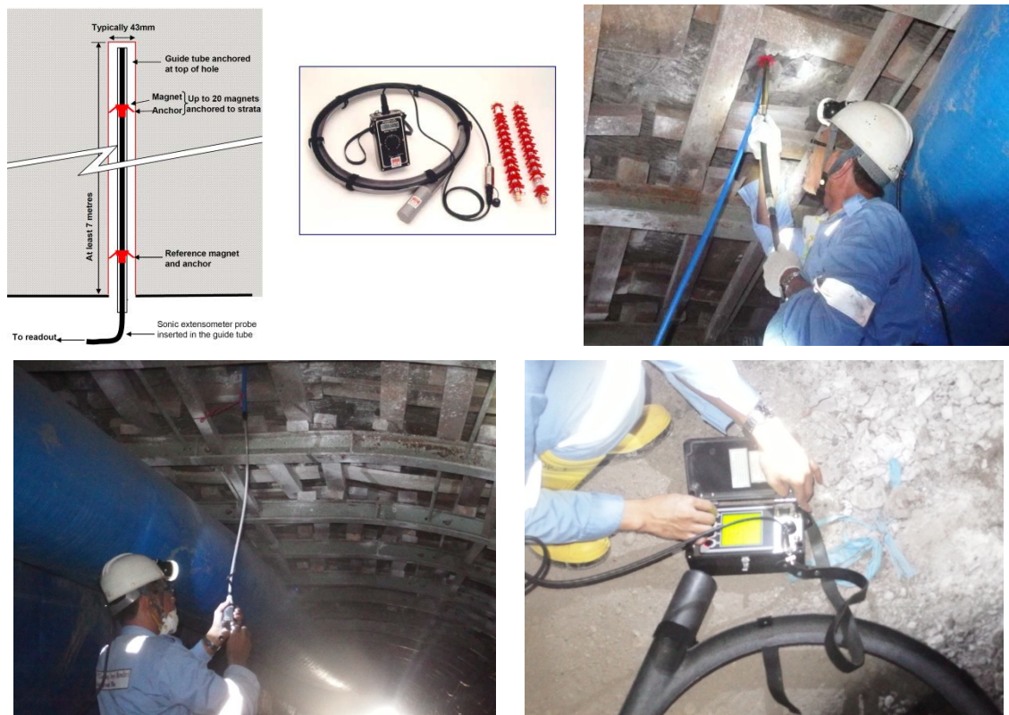
図 4.14 Extensometer 概略図および打設・計測作業
