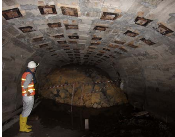
図 6.9 流動性粘土の坑内流入状況図
