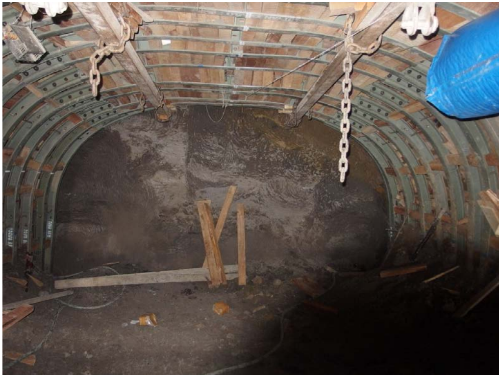
図 6.1 沖積層土内の掘進切羽状況
