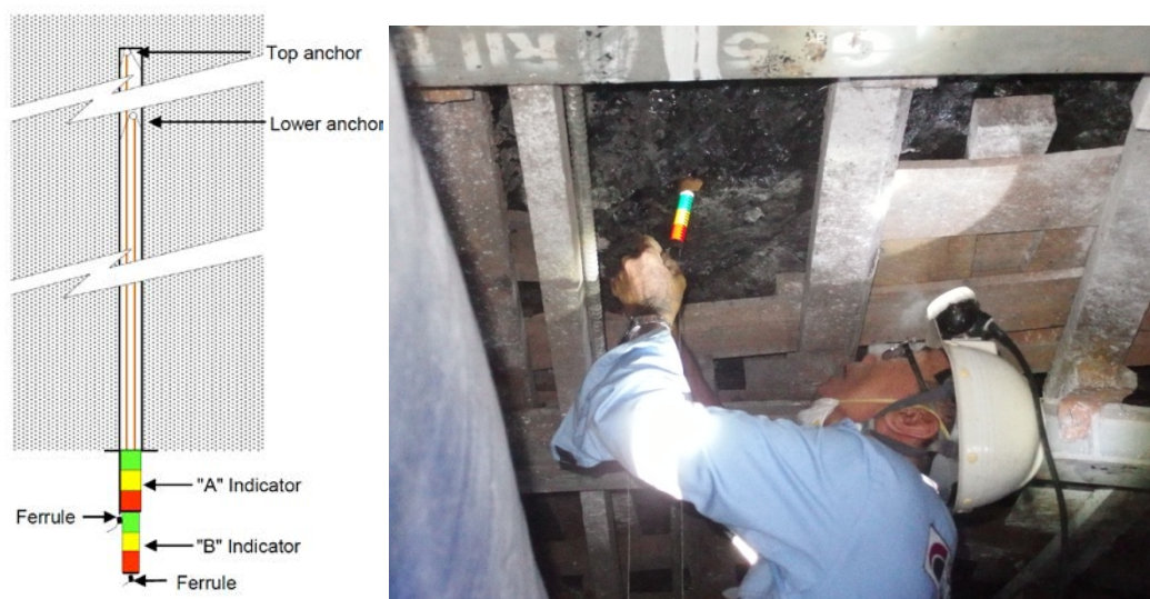
図 4.13 Telltale 概略図および打設作業
