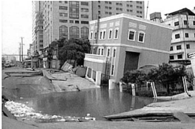
図 1.8 トンネル陥没に伴う地表建築物の倒壊状況[18]
