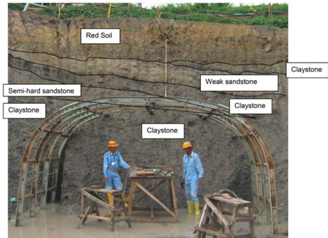
図 3.5 北斜坑口開設作業の様子
