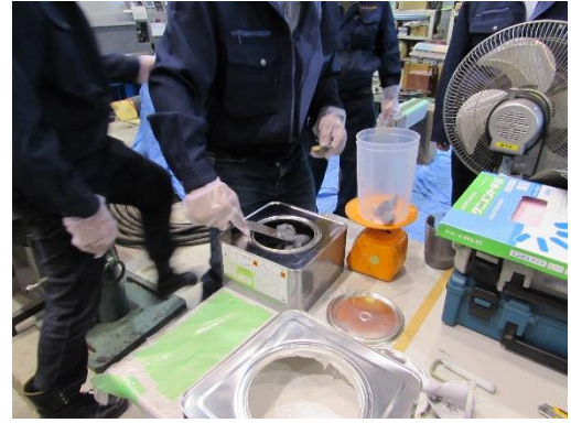
(c) Epoxy resin primer application (treatment \pm 4 hours) (d) Epoxy putty measurement (1600gr/m 2 )
