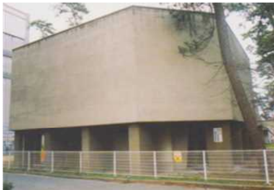
図 57-1 ガンマ線照射実験室（上屋工事後）
