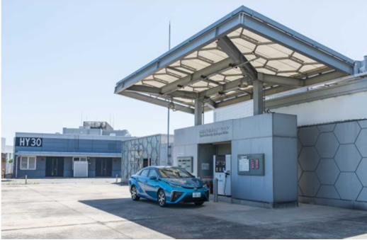
図 50-1 現在の水素エネルギー国際研究センター棟と水素ステーション（2015年6月）
