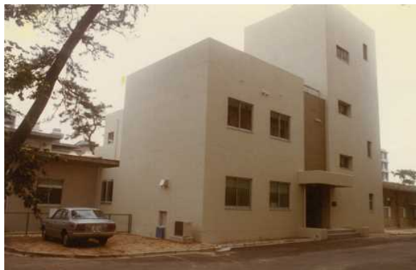
図 31-2 3 棟増築後の箱崎地区実験室
