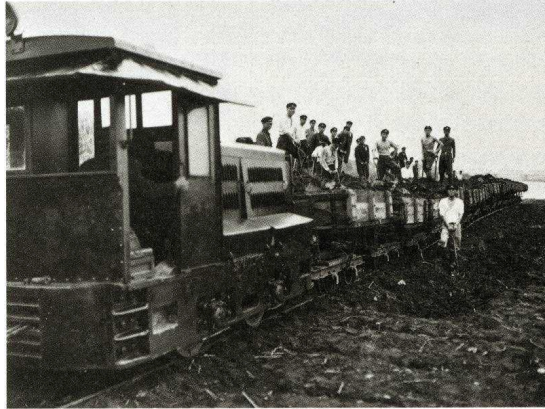
しかし同地で3万坪 図4-24 運動場整地作業(1940年)
