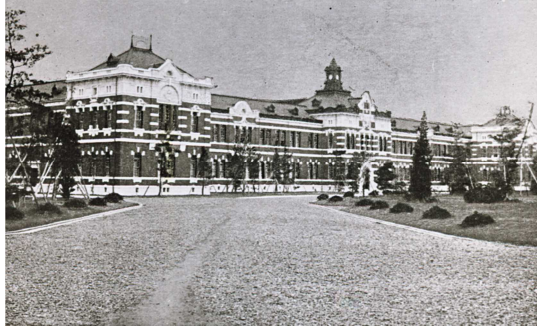
図2-2 大正期の工科大学本館
