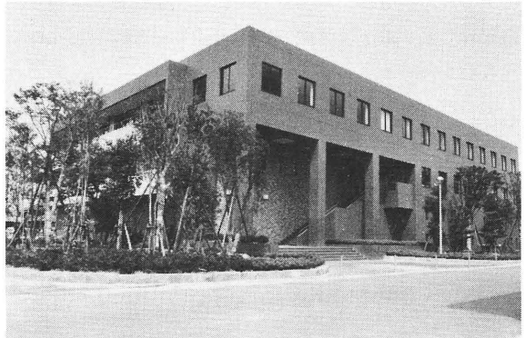
教養部分館 (前庭より玄関を望む)
