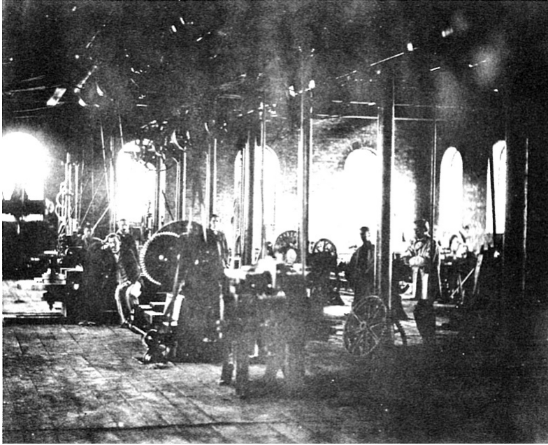
写真8 飽之浦製鉄所内部。蒸気機関が動力源として使用されている。指導にあたったオランダ人技師も映っている。出典：後藤和雄、松本逸也編『甦る幕末写真集ライデン大学写真コレクションより』 [45, p. 135]。
