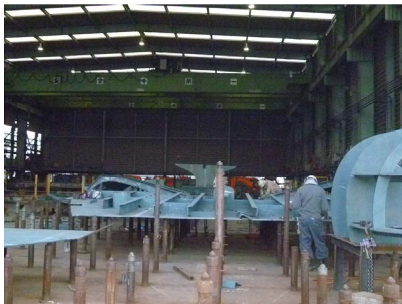
Fig.4-6 建屋内作業区画 K5 の様子
