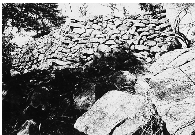
本城 櫓形 南面 不等辺五角形であることがわかる。 周辺には崩落石がおびただしかった。修理によって積 み直されたい。
