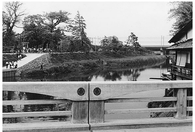
拡幅前の五条川と五条橋
