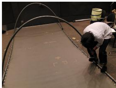
図 2-25 テンションバーの差し込み
