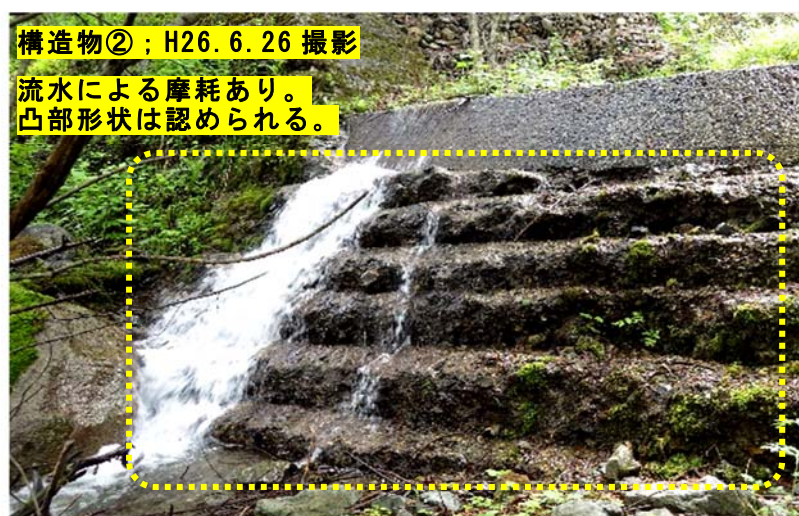
写真 4.4-9 INSEM 護岸の外観（常時流水地点）
