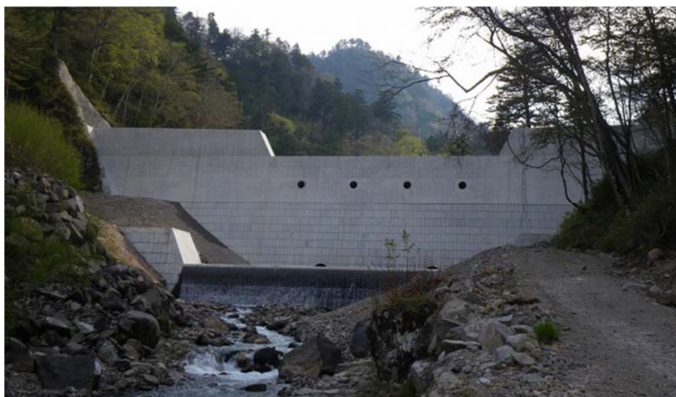
写真 4.3-2 完成後の検討対象砂防堰堤
