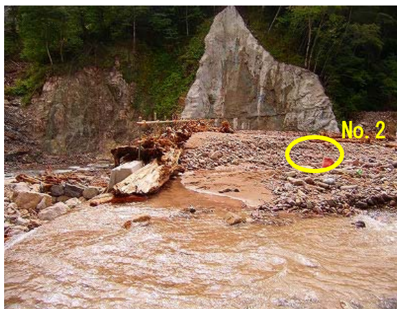
(摩耗調査箇所の被災直後状況；H19.9.13)
