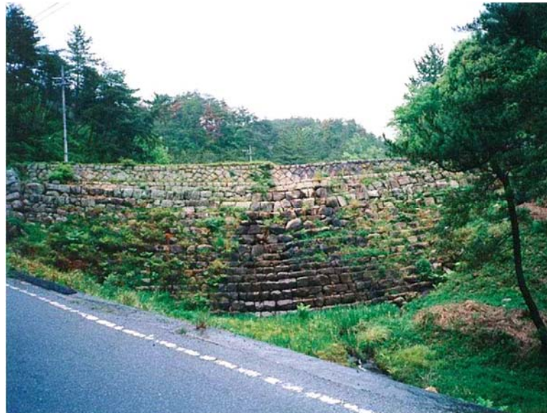
写真 2.1-1 石と土で作られた旧福山藩の砂留工（堂々川 6 番砂留工）
