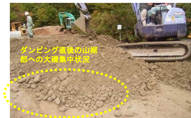
写真 5.3-5 ダンピング直後の大礫集中箇所
