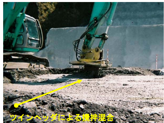
(ツインヘッドによる攪拌混合状況)
