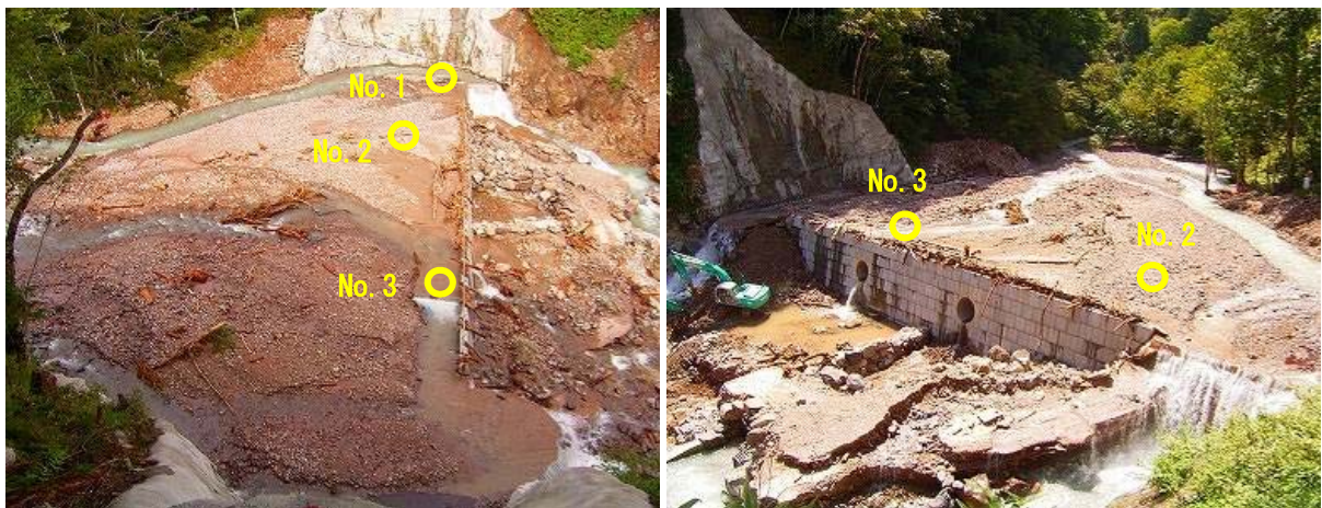
写真 4.3-5 INSEM 打設面の土石流被災事例（平成 19 年 9 月 13 日撮影）
