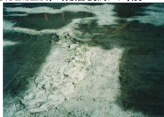
(打設面状況；打設翌日(約 15h 後))
