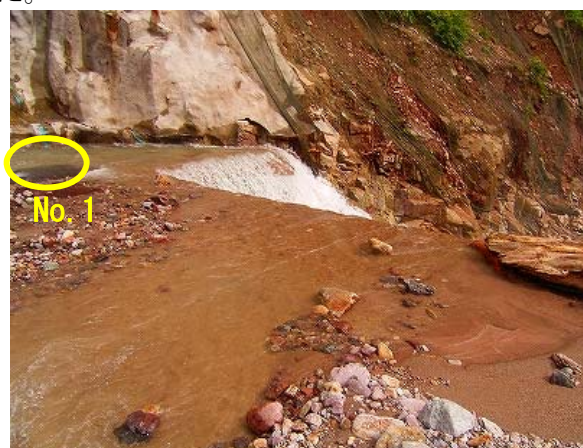
（摩耗調査箇所の被災直後状況；H19.9.13）
