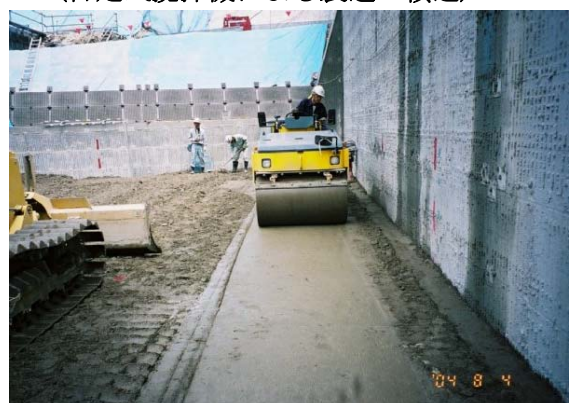
(振動ローラによる締固め)
