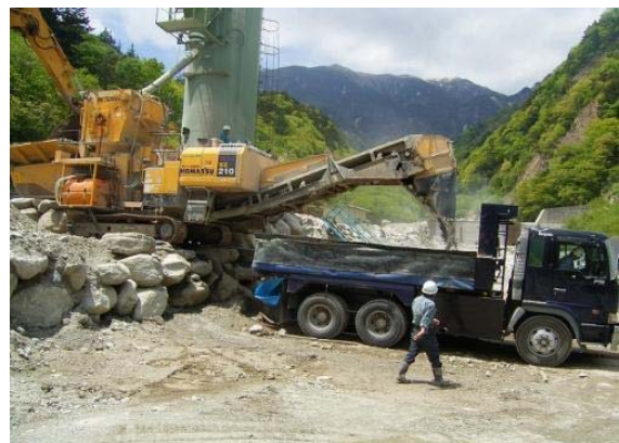
(自走式攪拌機による製造・積込)
