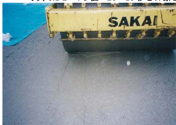
(打設面状況；打設時)
