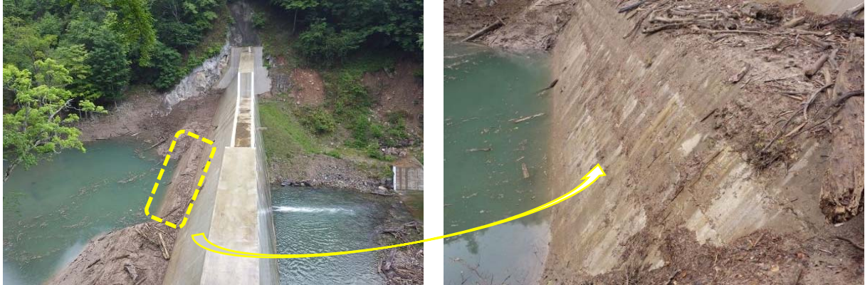
(全 景) (近 景) 写真 4.3-12 越冬 8 回経験後の付加断面箇所の状況・状態
