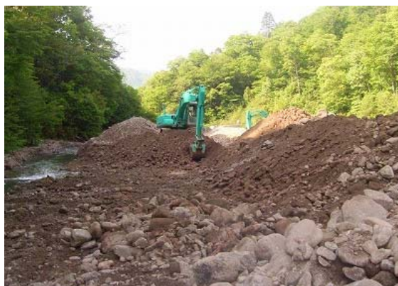
(スケルトンバケット付バックホウによる母材採取・分級)
