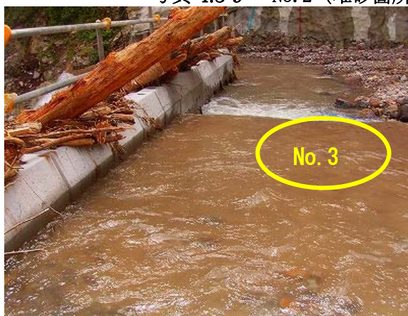
(摩耗調査箇所の被災直後状況；H19.9.13)
