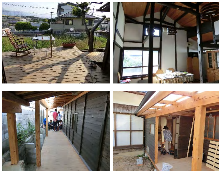
写真3 糸島空き家プロジェクトの改修事例
