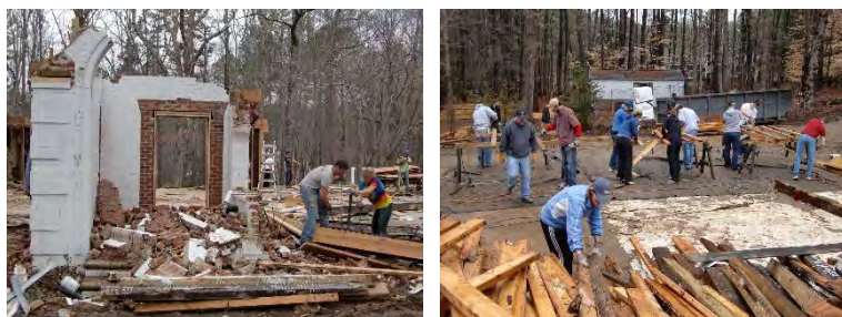
写真4 建築物の解体と解体材の金物撤去作業（米国 HfH）
