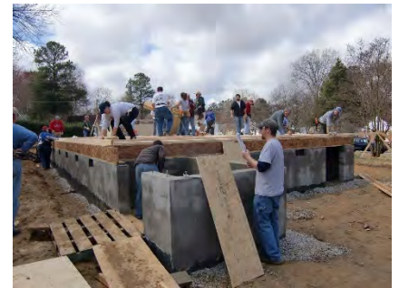
写真7 ボランティア参加型の住宅建設工事（米国 HfH）
