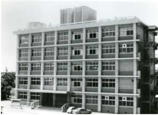
図 12-3 完成当時の歯学部基礎棟（1970 年）
