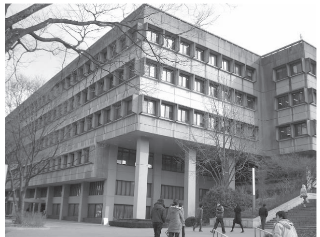
写真1 ソウル大学校中央図書館
