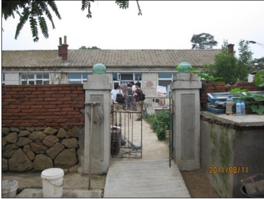
写真 1-1 外側から見る様子
