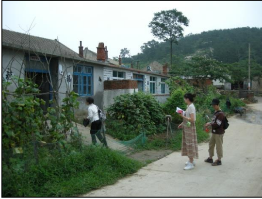
写真 8-1 外側から見る様子
