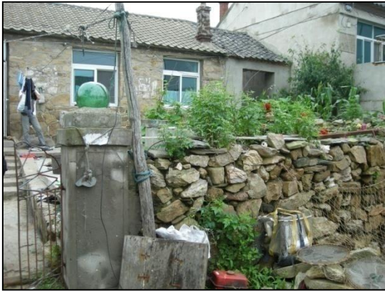
写真 4-1 外側から見る様子
