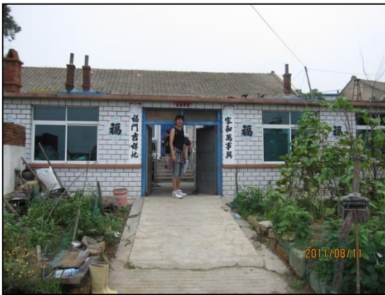
写真 9-1 外側から見る様子
