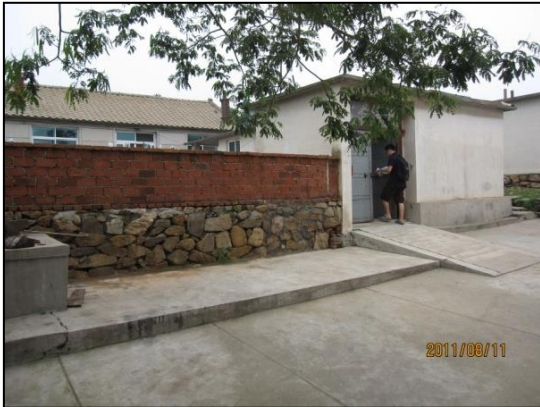
写真 7-1 外側から見る様子
