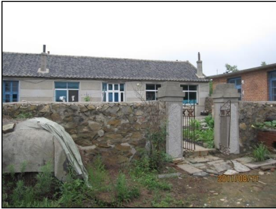
写真 3-1 外側から見る様子
