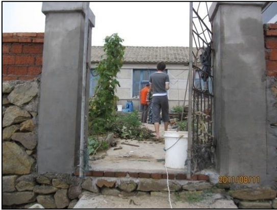
写真 5-1 外側から見る様子
