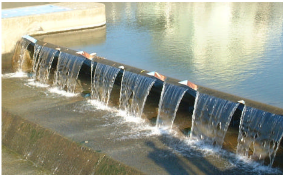
写真 2-2(a) Station13(刃型堰)
