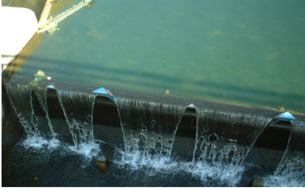
写真 2-2(b) Station14(刃型堰)
