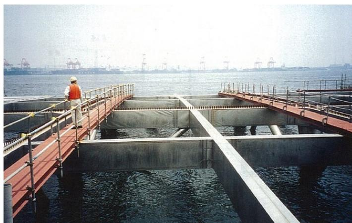
写真-3.2.1 大井埠頭ジャケット式栈橋の外観（下部工）
