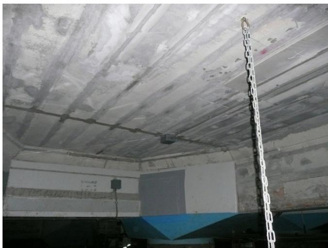
写真-4.1.1 断面修復と電気防食を適用した例
