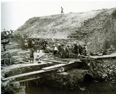
図3-21 金川門を撤去した時の様子<sup>32)</sup>
