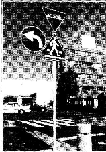
A：単体としての一本のポール構造。標識柱や歩行者専用信号などの低い装置に用いられている。
