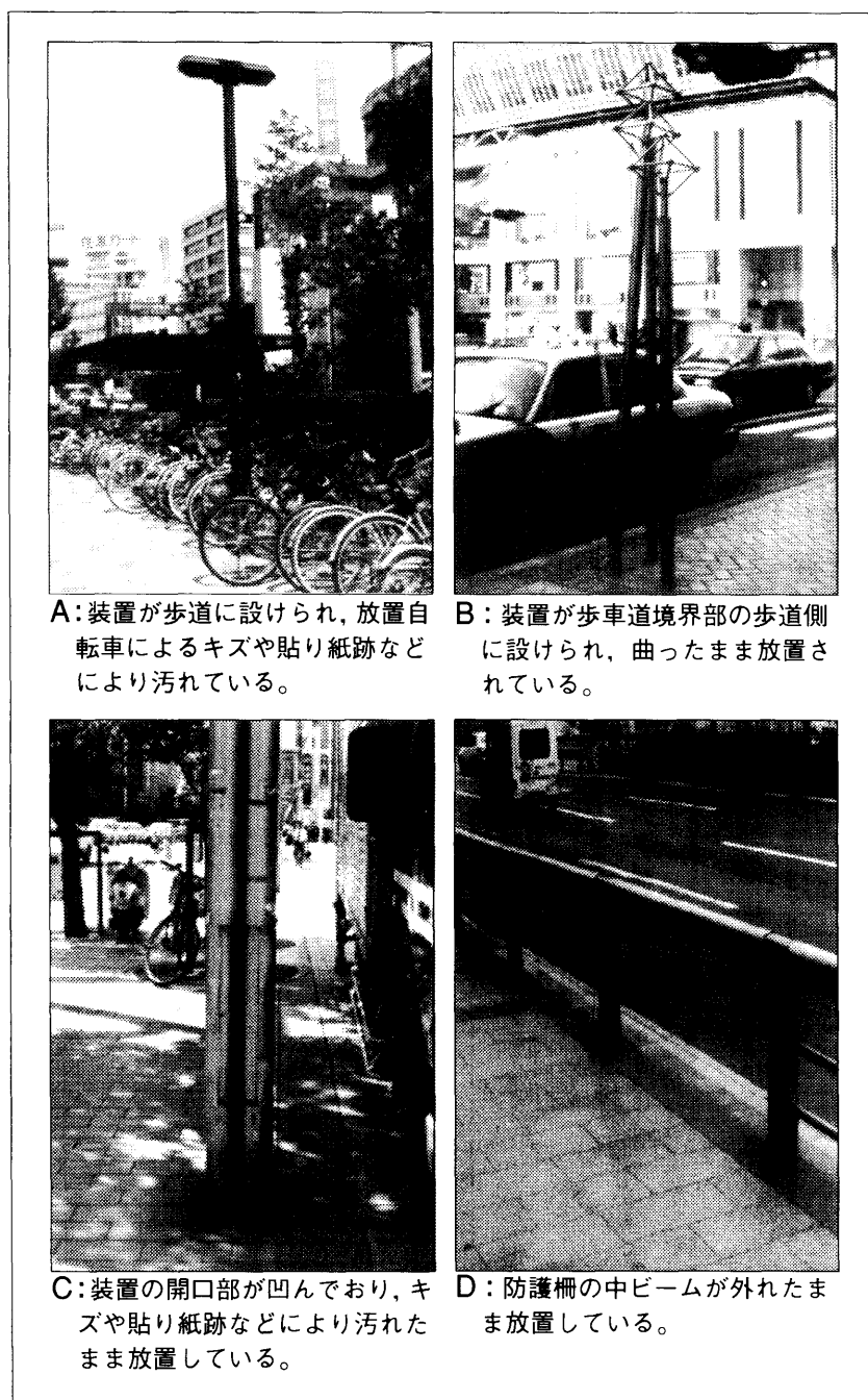
図3-1 既存のメンテナンス体制による装置の破損状況
