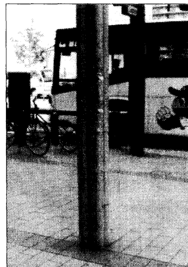
C：歩道の中央部のポールではステッカーやテープなどの貼り紙跡による汚れが多い。
