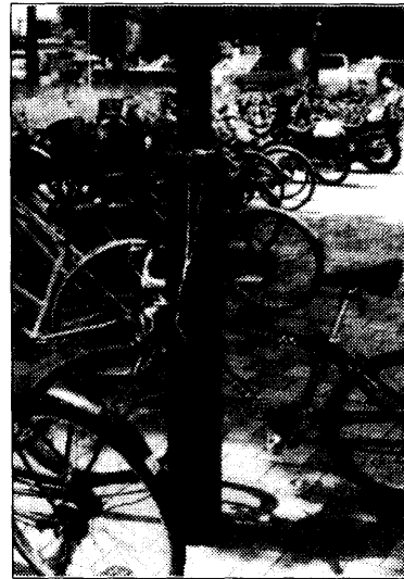
B：放置自転車が 많이 場所に設けられているポールの下段部は、キズが多い。
