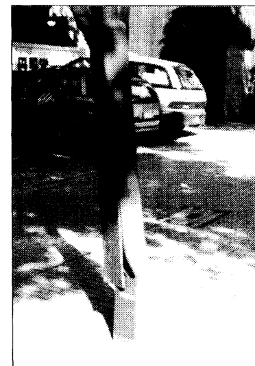
D：施設入口部周辺の歩道中央部に設置したポールが車の衝突により曲っている。
