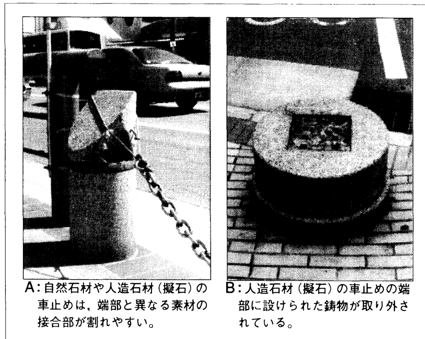
図 2-23 車止めの破損事例
