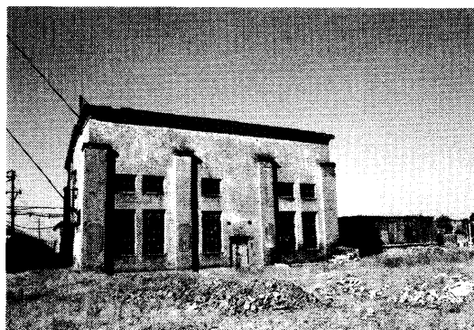
西堅坑捲揚機室
