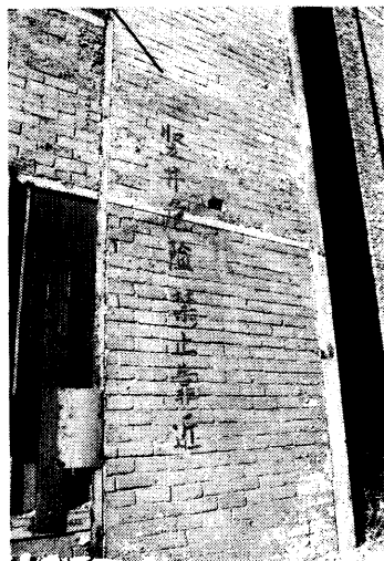
煉瓦と鉄骨の状態
