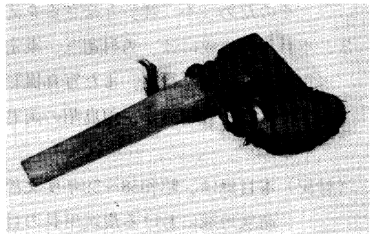
6. 仕繰斧 柄 306 刃長 150 刃幅 70 備考一手製カバー付
