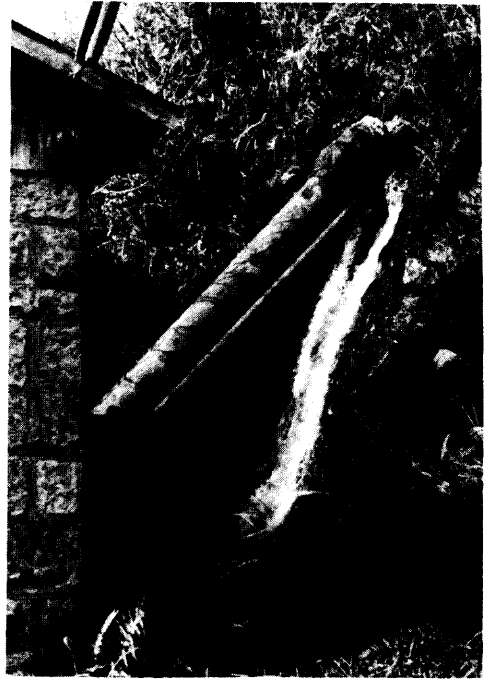
第6図 鹿屋市高須の製氷水車の導入管
