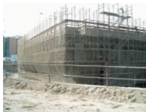
南東側からの工事状況
