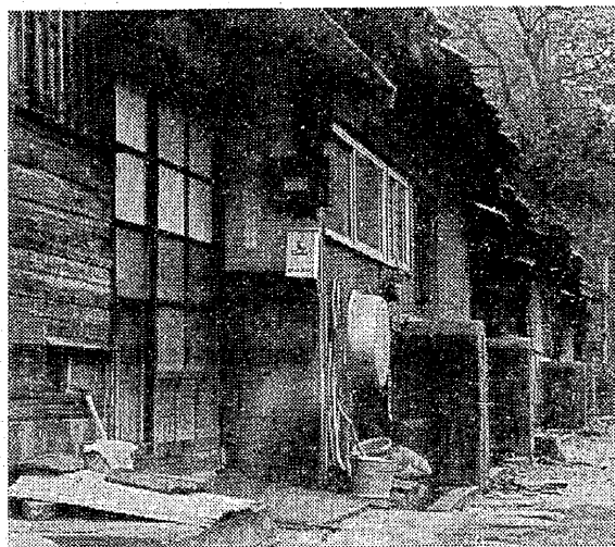
近代化された住宅の中へ踏み入れば、近代的な風。窓のサツシは自前で入れ替えたもの。
