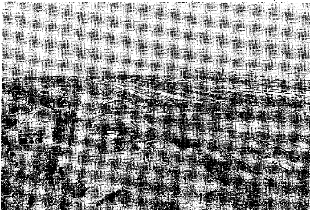
整然とならぶ四山社宅。しかし空戸も多い。労働者の住いは快適というには程遠く、環境整備もおくれており、たたかひの成果が待たれる。
