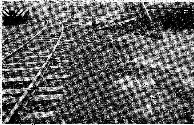
危っかしい新設の線路
