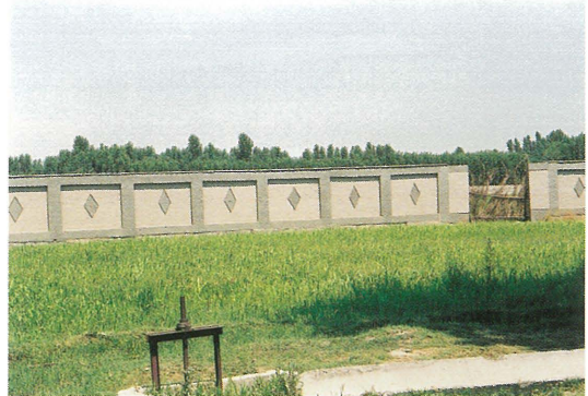
写真46 人造石洗い出しによる菱形 (ウズベキスタンのフェルガナ市郊外)
