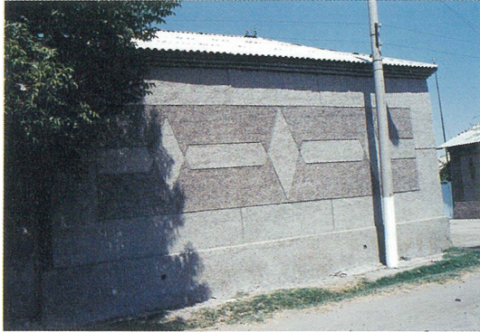
写真49 人造石洗い出しによる菱形 (ウズベキスタンのシザフ付近)
