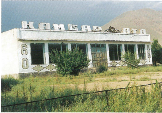
写真43 人造石洗い出しによる菱形 (キルギスタンのトクトグル近郊)
