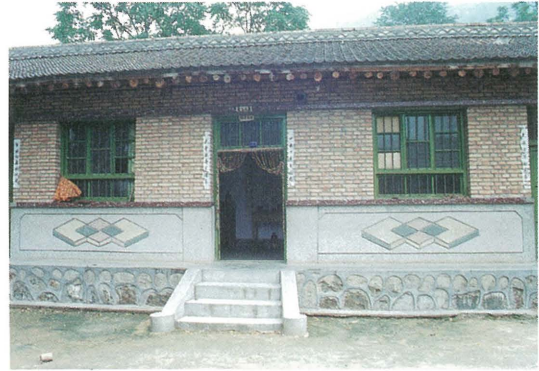
写真5 人造石洗い出しによる菱形 (甘肅省定西地区)
