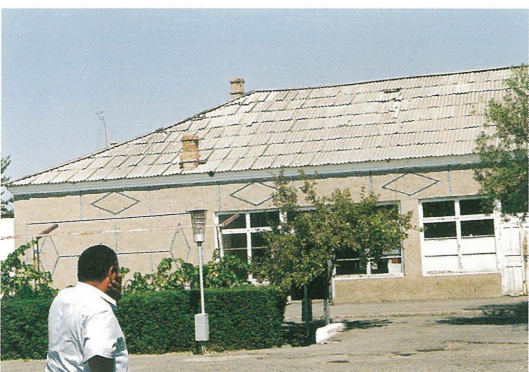
写真45 人造石洗い出しによる菱形 (ウズベキスタンのフェルガナ市郊外)
