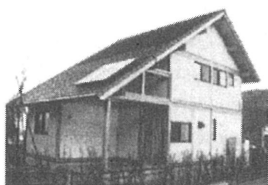
写真1 建物外観(南東側)
