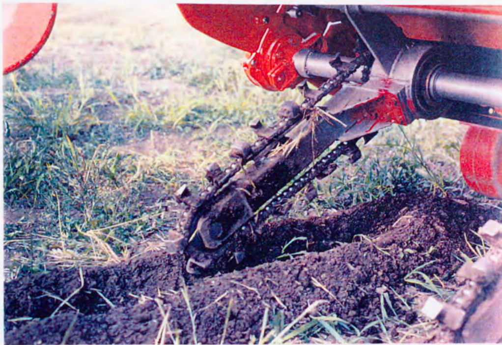
図 6 - 2 細溝暗渠の施工状況
