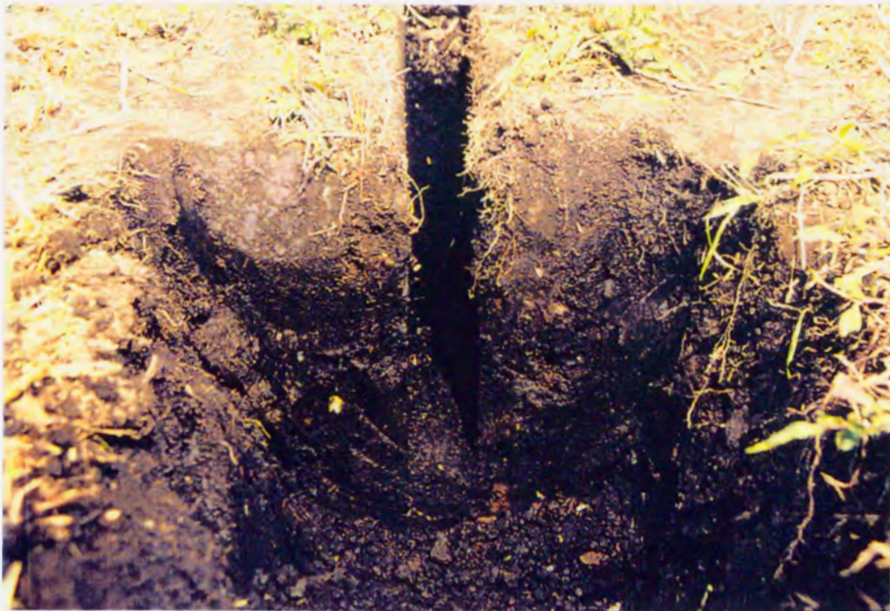
図 6 - 15 細溝暗渠の断面図
