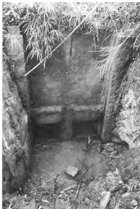
写真 V-11 改修以前の大日井樋 成富兵庫がおつぼ山神籠石の巨石を利用して作ったと伝承されている
