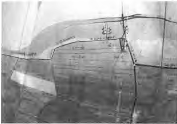
写真Q-6 明治初期 平松村絵図に画かれた樋門
