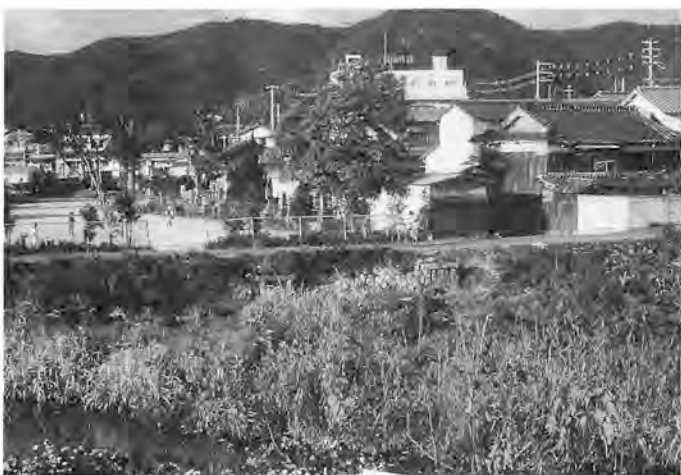
写真Q-5 つつきり樋門 西土井分〈右〉、および天満分〈左〉がみえている。この左にさらに天満分の大きな樋門があるが、写っていない
