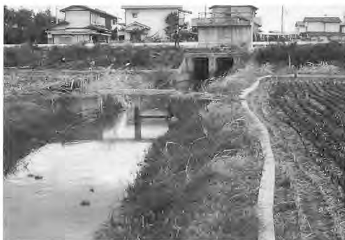
写真Q-4 くんがら樋門を内陸側からみる 既に改修されて、近代的になっている。樋門横の人物は著者の妻
