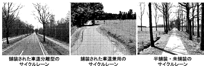
図9 舗装状態によるサイクルレーンの区分注5
